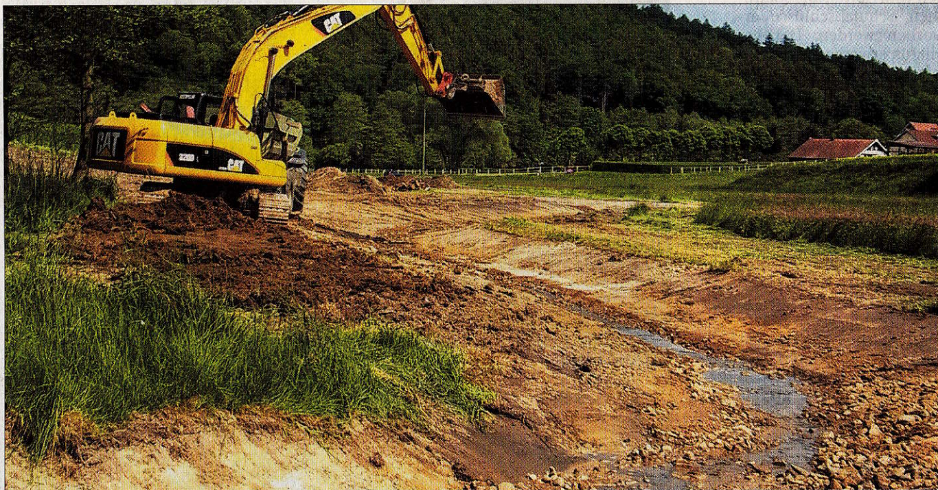
Ein lebendiges Fließgewässer entsteht in Meesdorf: Die SON lässt den kanalisiertem Bach naturnah gestalten.
