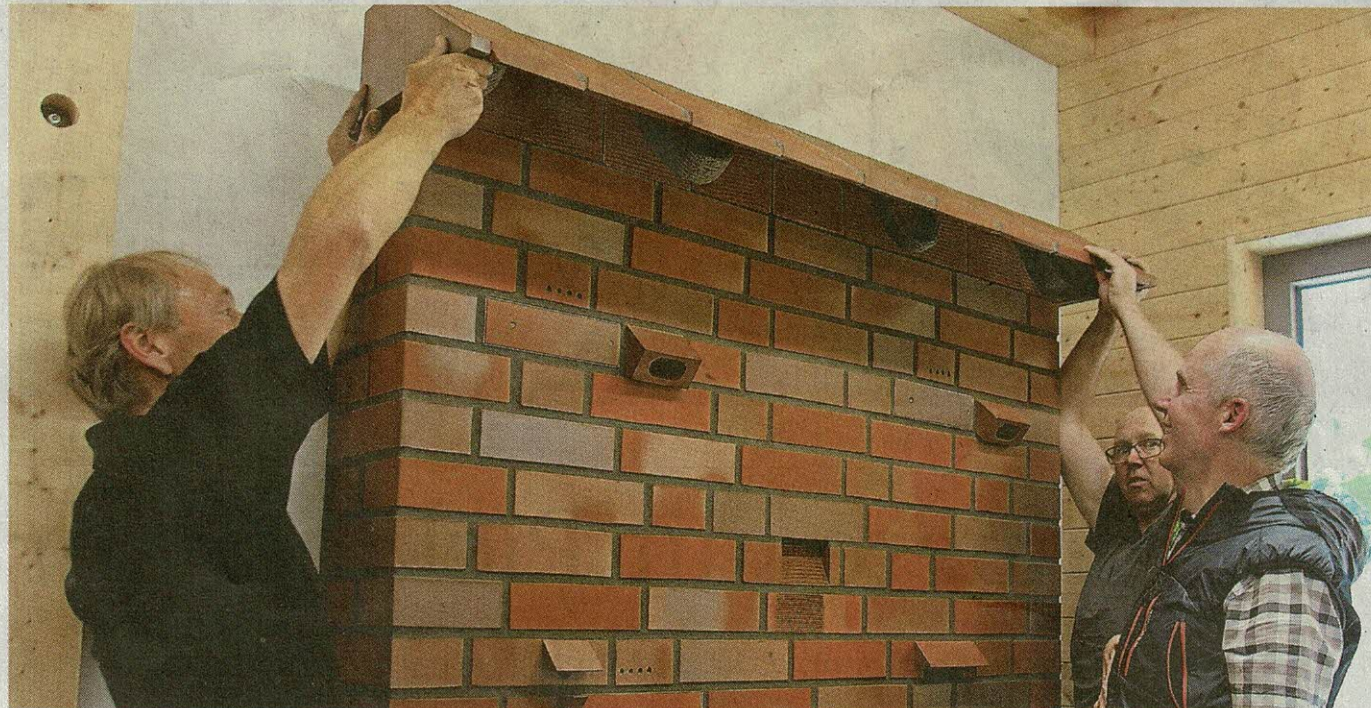
Setzen das Dach auf die Nistklinkerwand: Dietmar Klink, Volker Tiemeyer von der SON und Erfinder Hubert Rietmann (von links).
