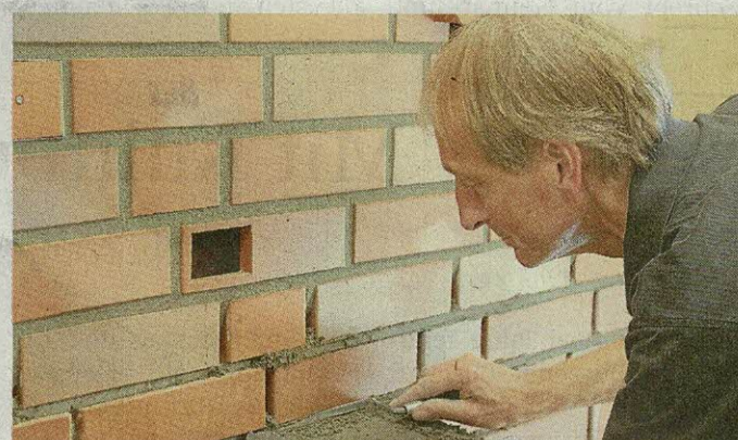
Dietmar Klink verfugt die neue Nistklinkerwand im Artenschutzhaus der SON.
