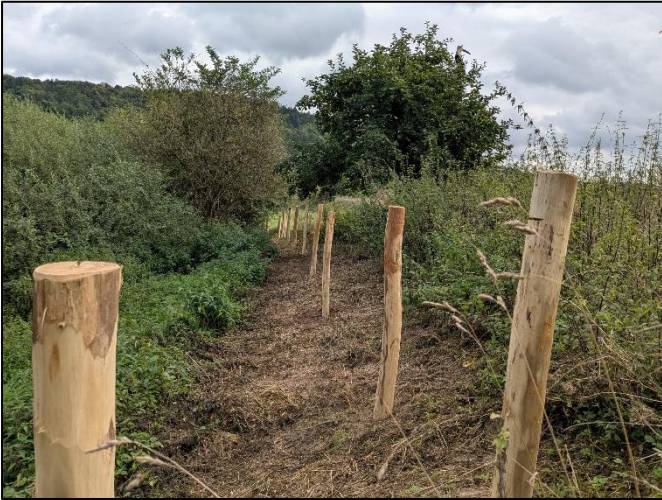
Abbildung 1: Das Errichten des Zaunes ist in nicht immer leichtem Gelände recht kräftezehrend. Foto: Volker Tiemeyer
