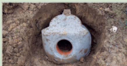
Abb. 5.2.2.12: Bodenteil eines Straßenablaufes als Winterquartier. Der Zugang wurde durch Firstpannen aus Ton gestaltet, deren Innenraum durch Bruchsteine verkleinert ist, um Prädatoren den Zugang zu erschweren. 25 Foto: Regina Haase, 03.02.2019
