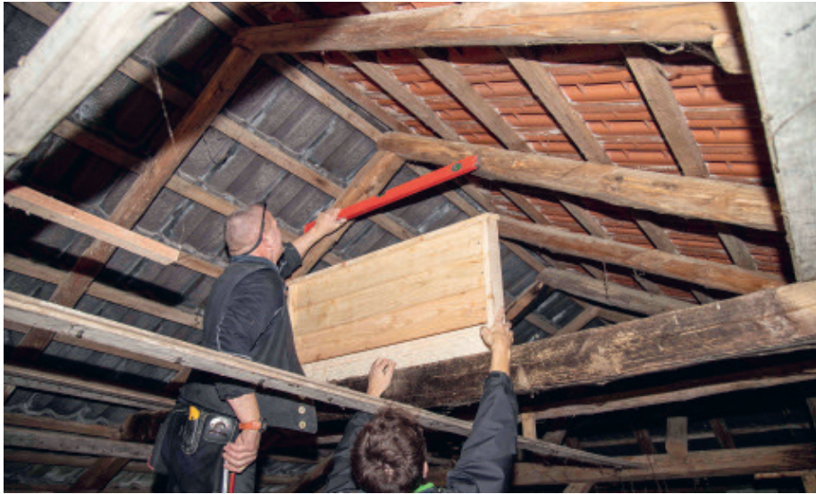
Abb. 9: Im Gebälk einer Scheune auf dem Hof Buschmeier wurden so genannte Fledermausbretter angebracht. Die dunkle, zugluftfrei Kammerung mit angerauten Brettern im Inneren bietet Hangplätze für Fledermausarten wie Fransen-, Breitflügel- und Zwergfledermaus.
