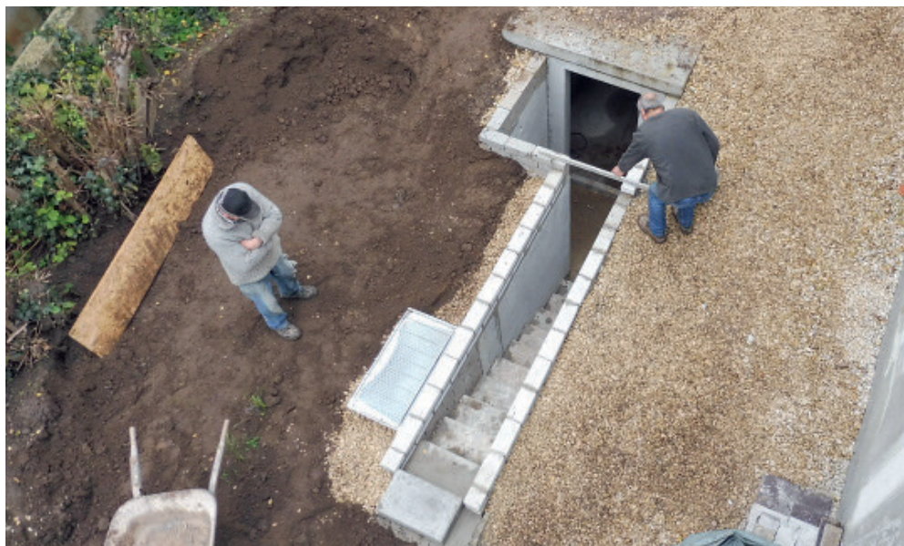
Abb. 15: Der Artenschutz-Keller im Rohbau aus der Vogelperspektive.
