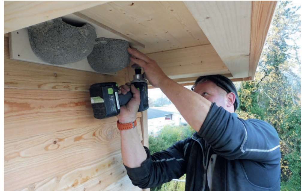
Abb. 3: Anbringung einer Nisthilfe für Mehlschwalben im Traufbereich des Dachgeschosses. Foto: Volker Tiemeyer, 20.11.2019
