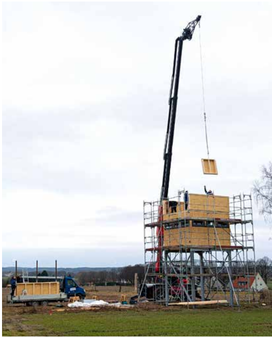
Abb. 1: Kurz vor dem „Richtfest“: Am 26.02.2025 wurden die vorgefertigten Elemente für den Beobachtungsraum und die Aussichtsplattform aufgestellt und zusammengefügt. Foto: Volker Tiemeyer
