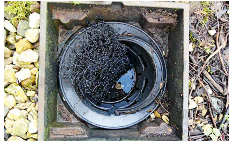
Abb. 14: Ausstiegshilfe für Amphibien aus Gullys aus dreidimensionalem Kunststoffgeflecht. Foto: Volker Tiemeyer
