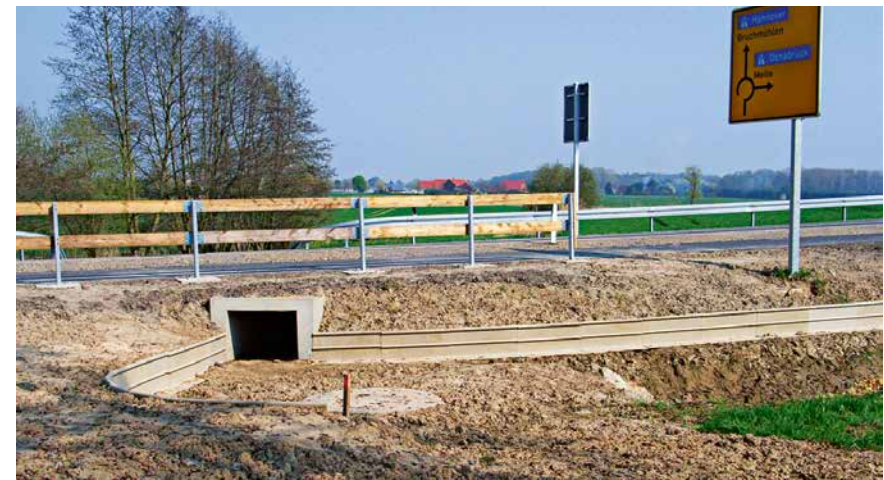
Abb. 13: Stationäre Schutzanlagen mit Leitsteinen und Tunnel wie diese 2009 an der Ortsumgebung Buer errichtete sind eine sehr effektive Schutzmaßnahme. Foto: Volker Tiemeyer
