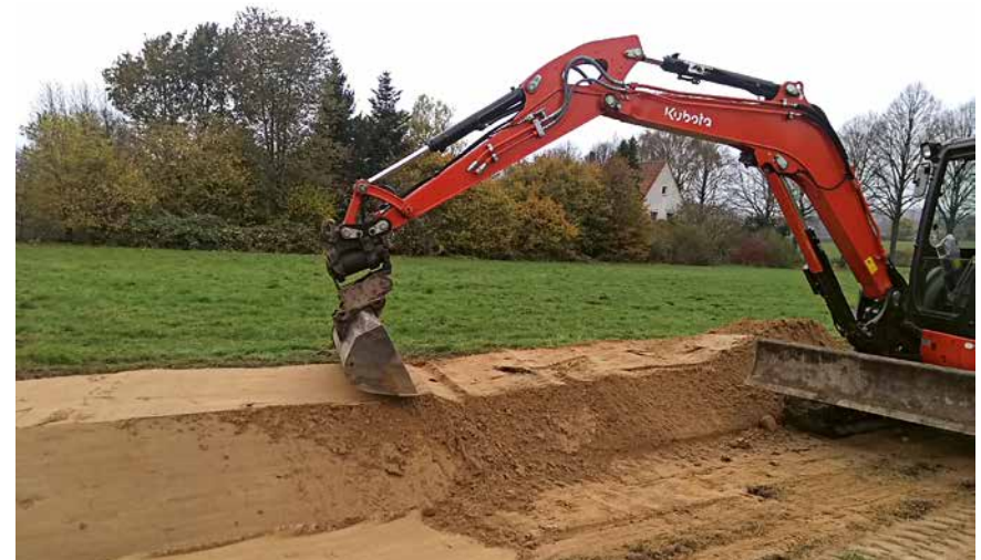
Abb. 3: Neuanlage der sogenannten Bienenwälle aus Sand aus dem Bodenabbaugebiet Markendorf/Bulsten. Sie haben eine Grundfläche von rund 2 m x 12 m und eine Höhe von etwa 0,5 m. Insgesamt wurden vier solcher Wälle auf dem Projektgebiet angelegt.
