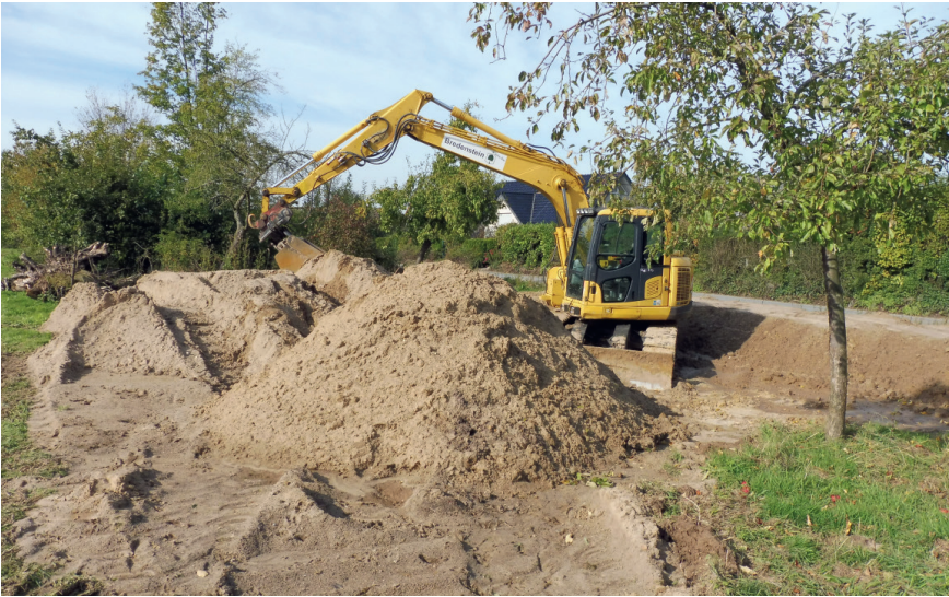
Abb. 4: Der Einsatz von Bagger und weiteren Großgeräten war erforderlich, um das rund 200 Quadratmeter große Areal am Ortsrand von Wellingholzhausen als Nistfläche für Wildbienen herzurichten. Foto: Volker Tiemeyer, 07.10.2019
