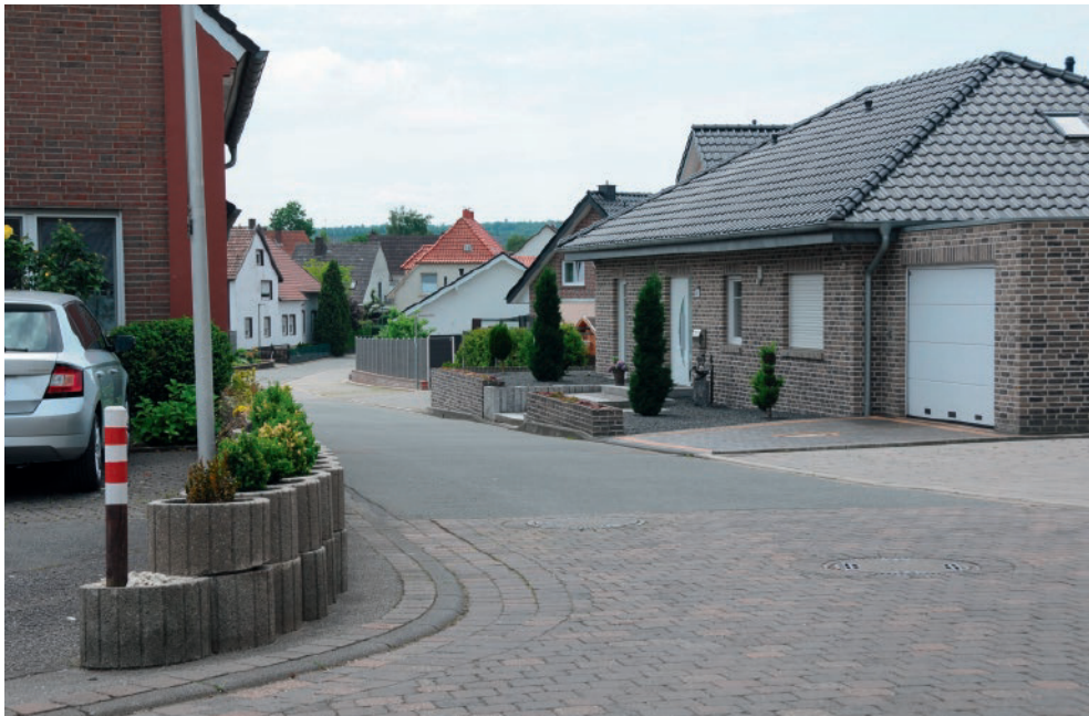
Abb. 2. Solche fast vollständig versiegelten, nahezu pflanzen- und schattenlosen Straßenzüge zeichnen sich an heißen Sommertagen durch wüstenhafte Bedingungen aus, die auch nachts nichts Erfrischendes bieten. Bei starken Regenfällen strömt sämtliches Wasser ohne eine Chance auf Versickerung direkt in die Kanalisation, was diese überlasten kann.
