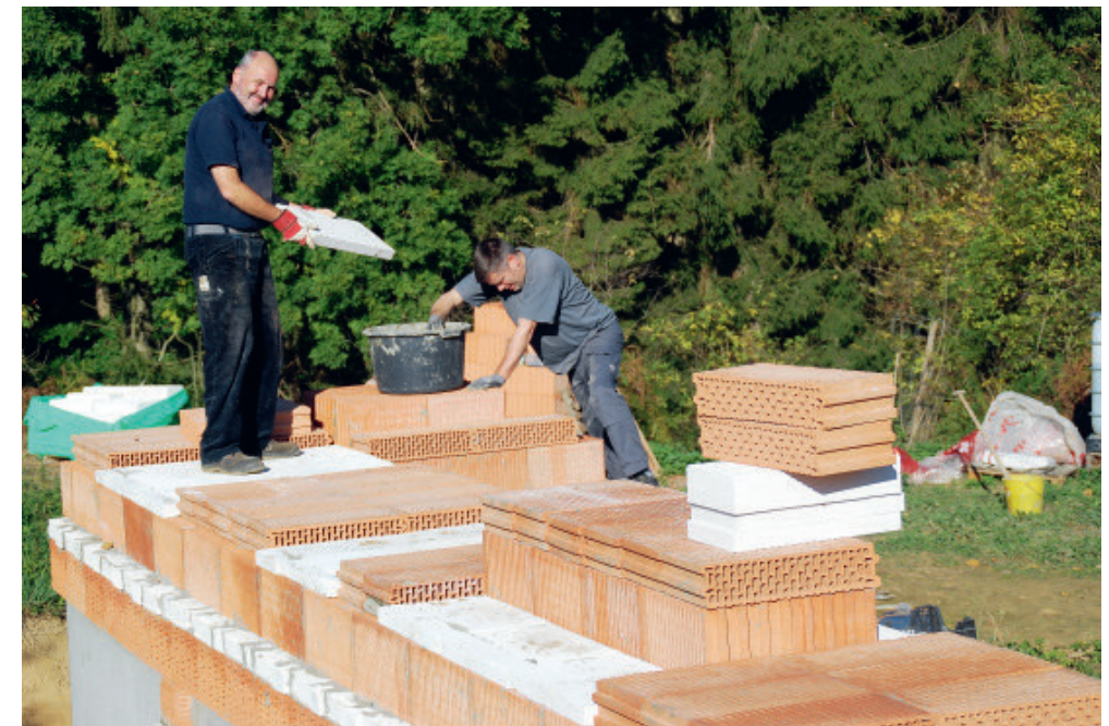
Abb. 5: Die Deckenkonstruktion des Stollens, die auch von Karl Schäffer (links) und Manfred Tzschachmann umgesetzt wurde, ist komplex und teilweise mehrschichtig. Foto: Gerhard Hagensieker, 06.10.2018
