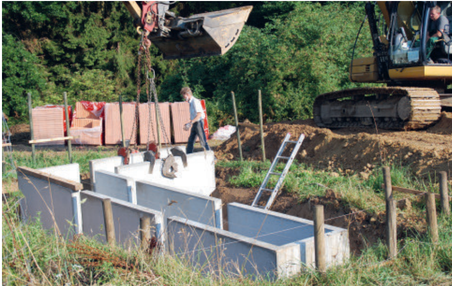
Abb. 2: So genannte „U-Profile“ aus Beton, die nach Maß angefertigt wurden, bilden das Grundgerüst des Fledermaus-Stollens. Der verwinkelte Bau sorgt zudem für eine Zonierung, die die Besiedlung durch Fledermäuse fördert. Foto: Gerhard Hagensieker, 26.07.2018
