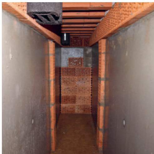
Abb. 6: Da die glatten Betonwände der Grundkonstruktion des Fledermaus-Stollens sich natürlich nicht als Hangplätze eignen, wurden an unterschiedlichen Orten im Stollen Spaltenquartiere angebracht
