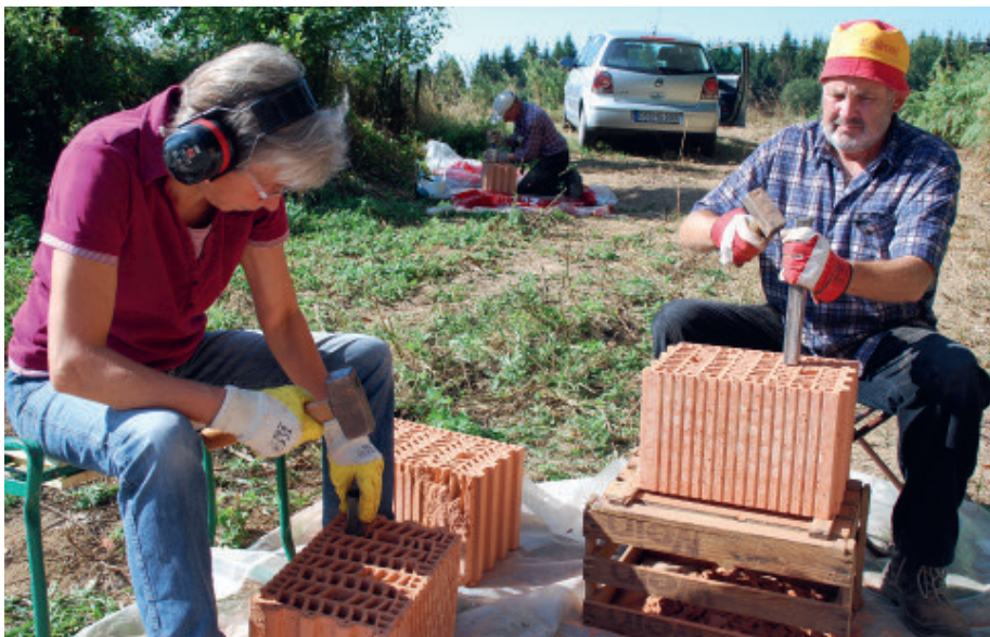
Abb. 3: Bis die Handgelenke schmerzten. Monika Schengber und Karl Schäffer scheuten nicht vor der mühselig Tätigkeit zurück: Aus rund 320 Poroton-Hohlziegelsteinen (Wienerberger-Hohlkammersteine der Druckfestigkeitsklasse 8, 37x24x25 cm groß) wurden jeweils 6 – 8 Stege mittels eines eigens gefertigtem Werkzeugs herausgestemmt. In Gänze wurden rund fünf Tonnen von Hand bearbeitet. Foto: Gerhard Hagensieker, 18.08.2018
