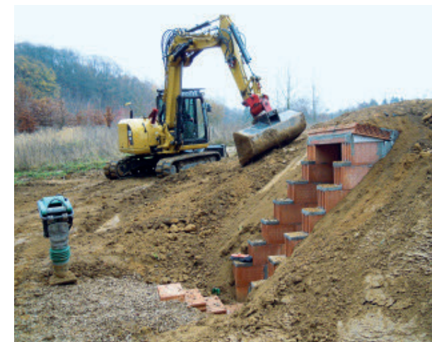
Abb. 7: Frostfrei muss ein Winterquartier für Fledermäuse sein. Deshalb wurde der Stollen mit Sand und Lehm überwallt.
