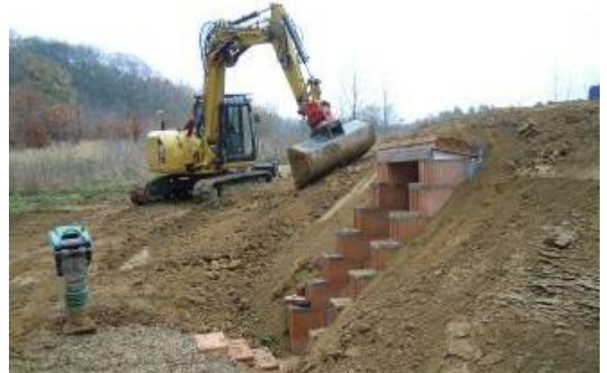
Letzte Erdarbeiten am neugeschaffenen Fledermausstollen. Foto: Karl Schäffer
