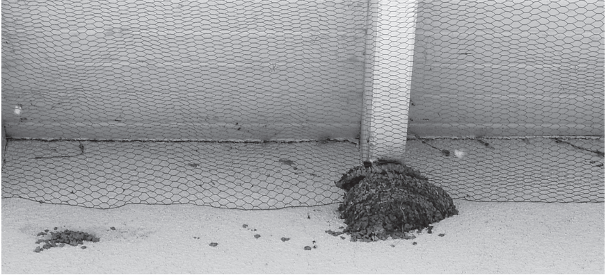
Abb. 4 Mehlschalben-Abwehrmaßnahme wie diese in der Meller Innenstadt mittels unter der Dachtraufe angebrachtem Sechseckgeflecht sind in mehrfacher Hinsicht fragwürdig.
