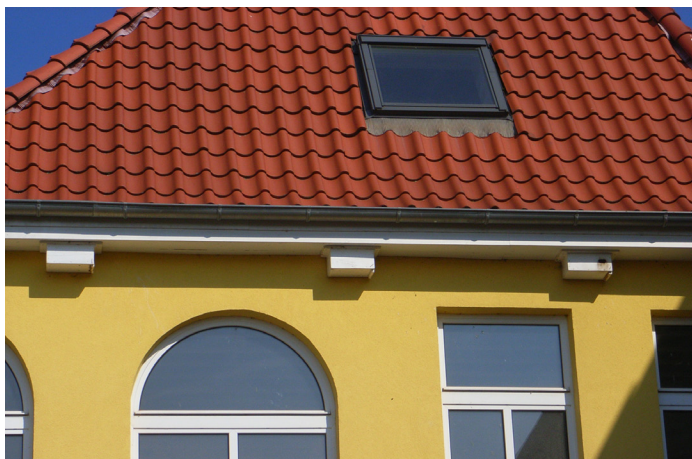
Abb. 1: Mauersegler-Nisthilfen im Ortskern von Buer. Nach umfangreichen Sanierungen ist der Mauersegler in Ermangelung alter Mauernischen immer stärker auf Nistkästen angewiesen. Foto: Volker Tiemeier, 28.05.2012.
